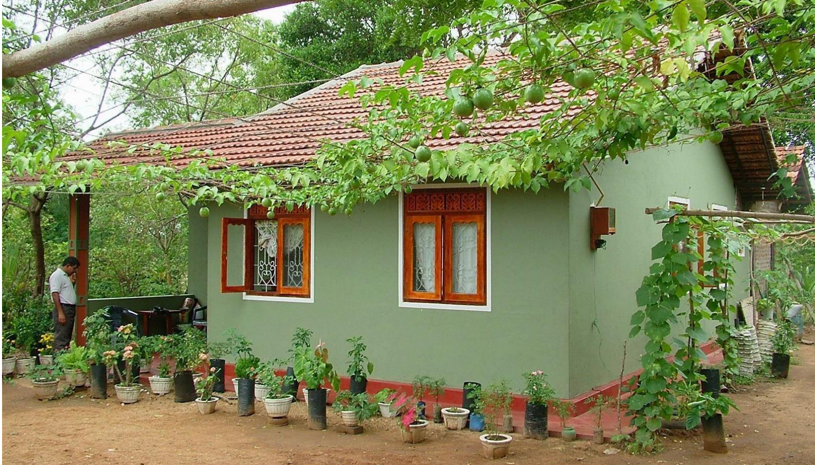
Casa renovada después del tsunami de 2004 en la cooperativa de viviendas de Siriyagama, Sri Lanka (©We Effect)
